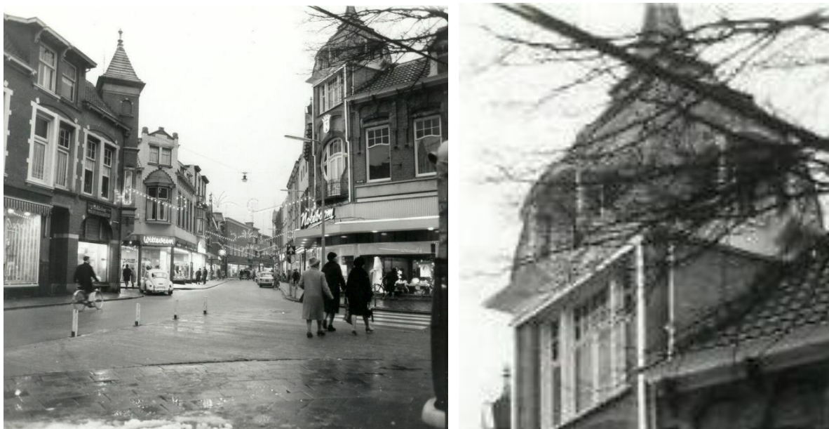
Nieuwe, peervormige torenspits
