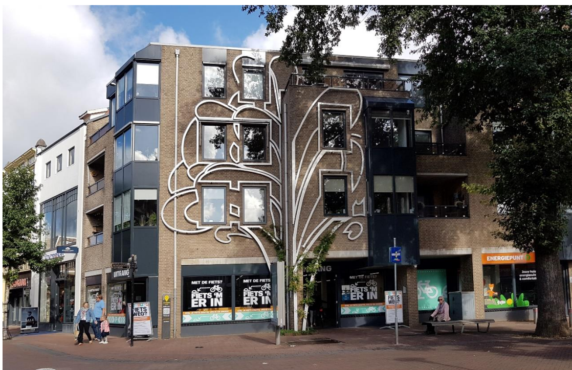
Fietsenstalling hoek Hoofdstraat Paslaan
