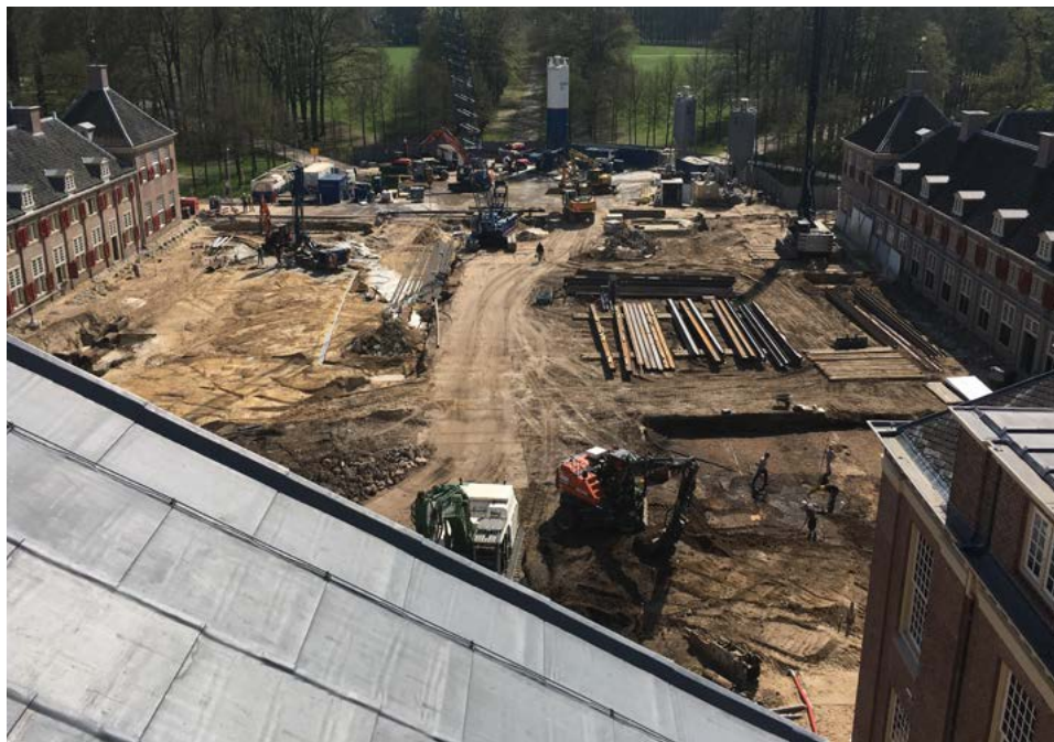
Afbeelding 4. De opgraving was een logistieke uitdaging en werd uitgevoerd tussen allerlei sloop- en bouwwerkzaamheden in.
