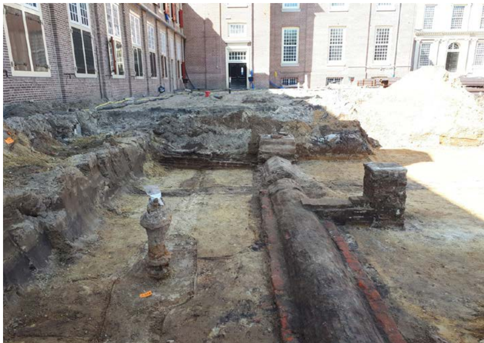
Afbeelding 5. De originele riolering van Paleis het Loo was nog opmerkelijk intact aanwezig.
