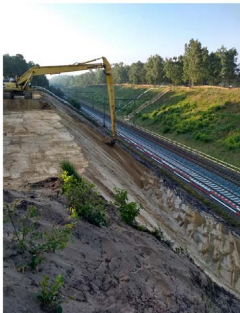
Afbeelding 22. Het graafwerk voor het ecoduct bij de Asselsche Heide gebeurde met groot materieel. De machinisten waren echter goed geïnstrueerd op welke sporen en vondsten ze moesten letten (foto: T&A Survey).
