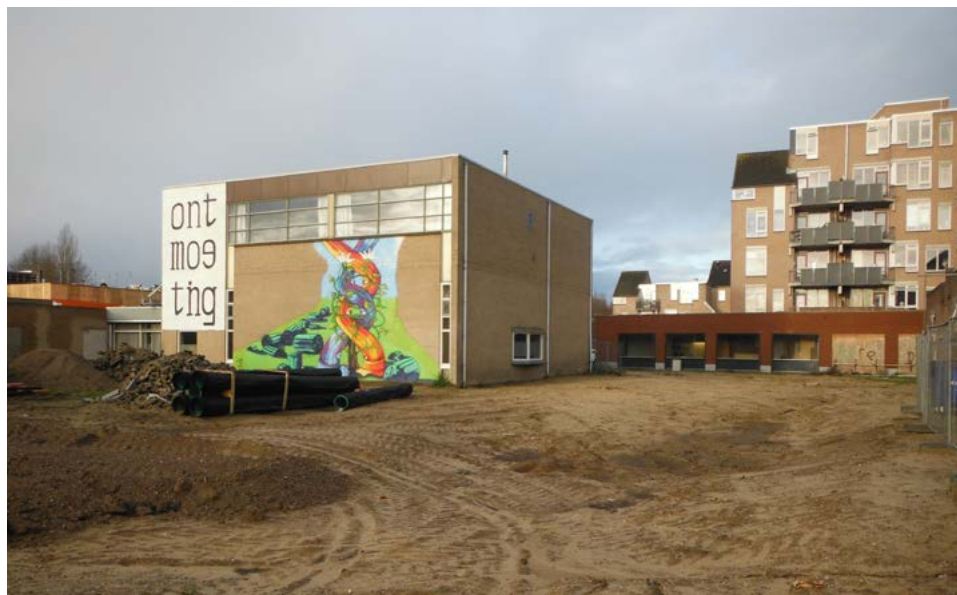
Afbeelding 2. Bij de graafwerkzaamheden bij de Eglantier in de Maten is een archeologische waarneming gedaan (foto: Econsultancy).
