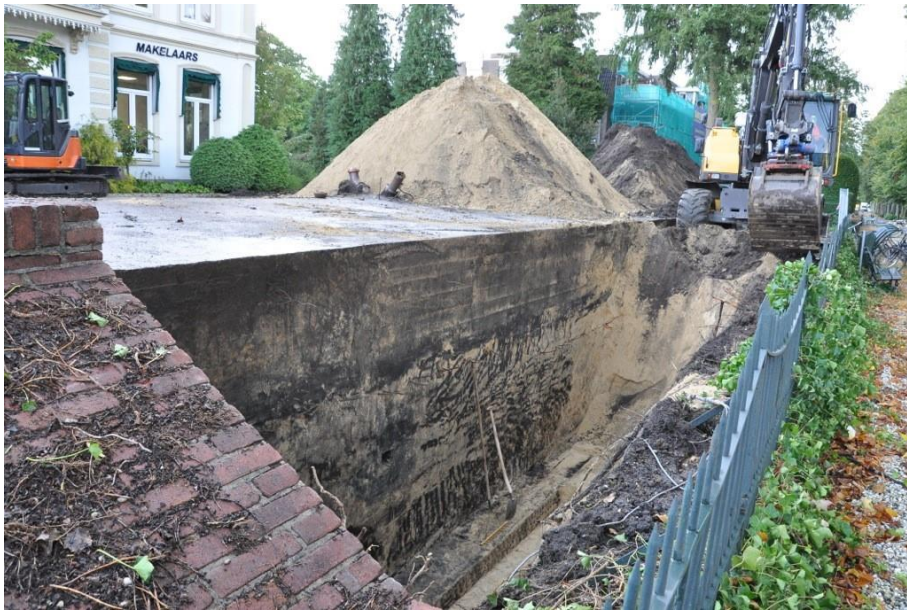
Foto 13. Restauratie bunker Seyss Inquart.
